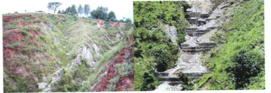
चित्र 50: भू कटाव को रोकन और जल निकासी बढ़ाने के लिए नाली/जलमार्ग में निर्मित चेक डैम
